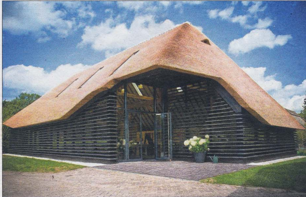
De buitenkant van de opgeknapte Vlaamse schuur van de familie Oomen.
